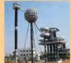
1200kV CVT under test
